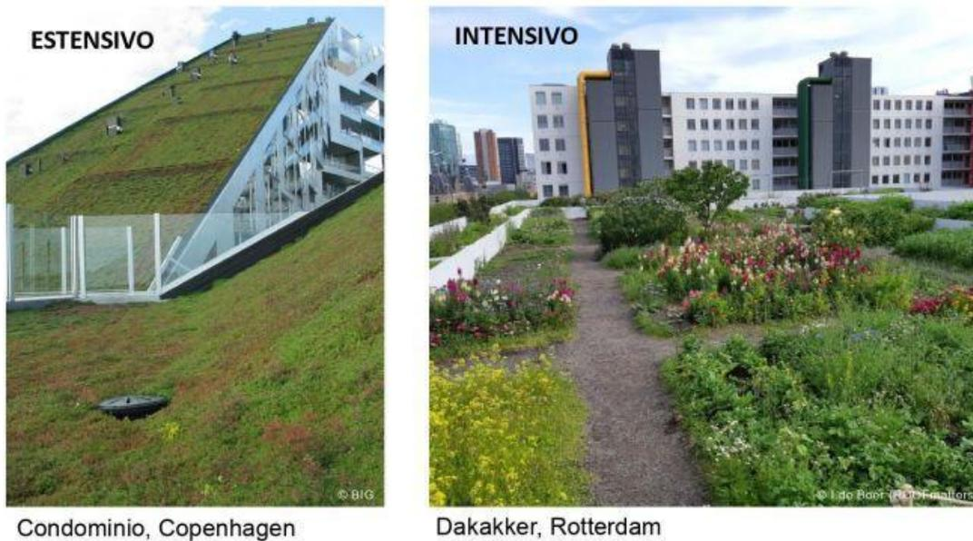
Figura 10 Tetto verde intensivo ed estensivo<sup>31</sup>
