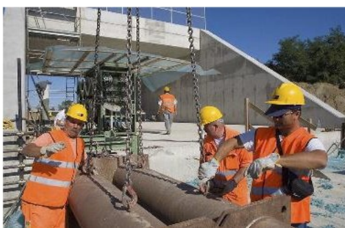
Un cantiere della Cmc nel 2006 per il sottopasso dell'Adriatica (Foto Zani)
