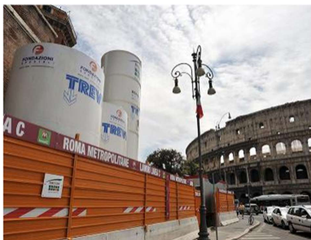
Il cantiere della Trevi per la nuova linea della metropolitana di Roma
